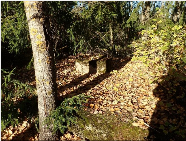
Rakenne H, n. 50 cm korkea betonilaatta 2,5 x 3,5 m ja sen keskellä pyöreä, ontto betonirakenne josta pistää ulos rautoja.
