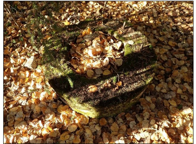
Rakenne H, n. 50 cm korkea betonilaatta 2,5 x 3,5 m ja sen keskellä pyöreä, ontto betonirakenne josta pistää ulos rautoja.
